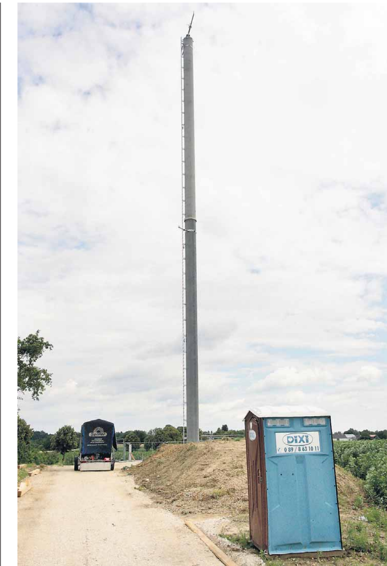
Schön sind sie nicht, die neuen Masten für den Digitalfunk – hier ein Exemplar bei Berg im Landkreis Freising. Aber ist die Technik auch gefährlich? Darüber wird noch gestritten. Foto: Marco Einfeldt
