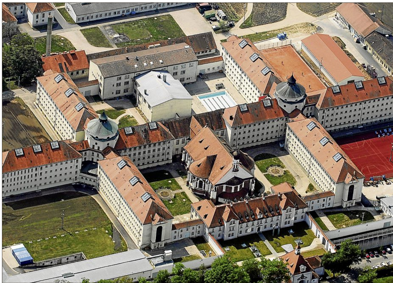
1,8 Millionen Euro lässt sich der Freistaat die Personen-Notsignal-Anlage (PNA) der JVA Straubing kosten. (Foto: dpa)
